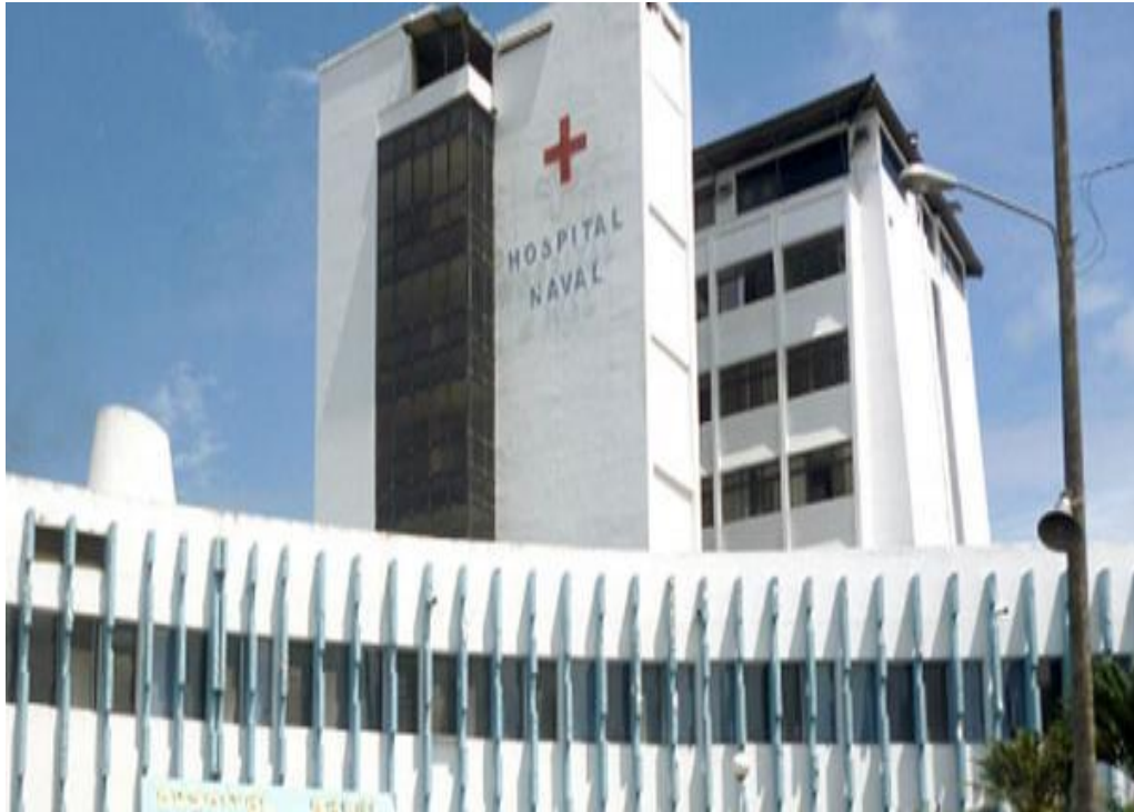
Figura 19. Edificio del Hospital Naval Guayaquil
