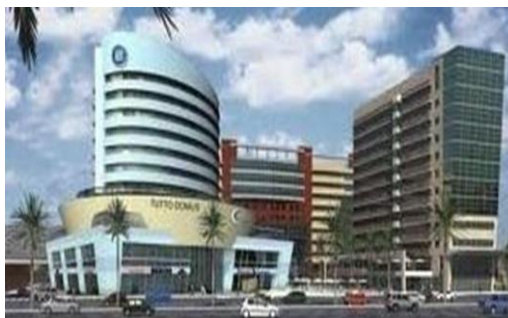
Figura No. 2 Infraestructura de La empresa
