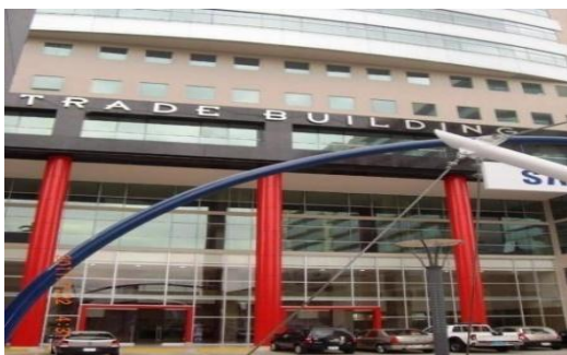
Figura No. 1 Infraestructura de La empresa
