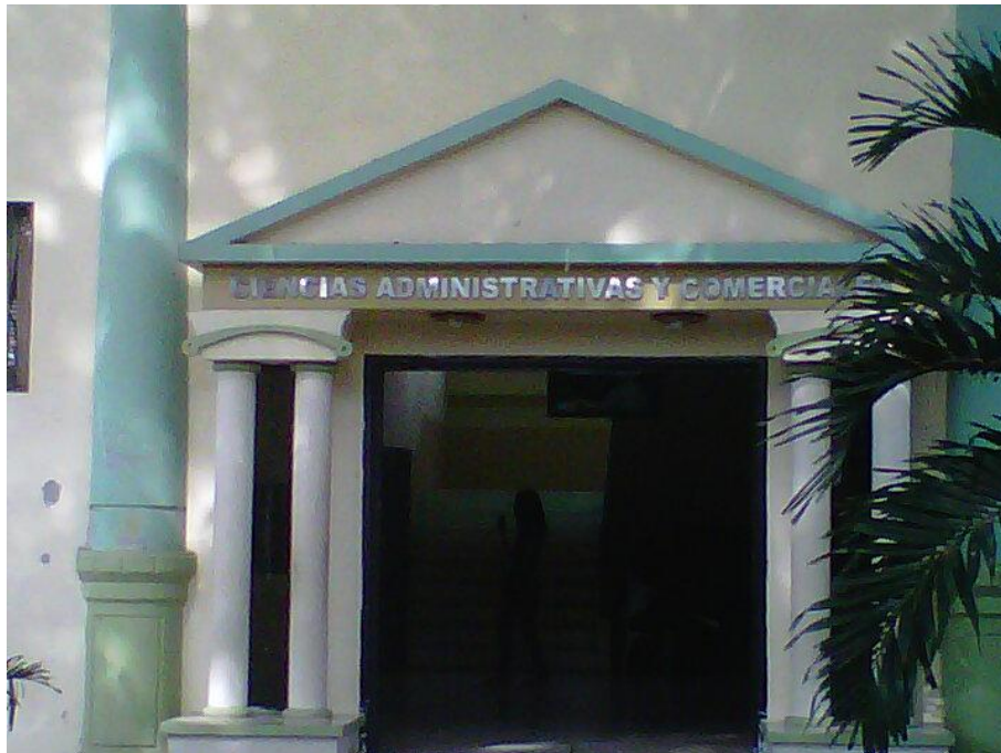
Figura 9 Unidad de Ciencias Administrativas y Comerciales
