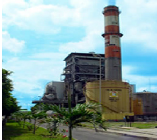
Figura 3. Imagen de la Central Termo Pichincha
