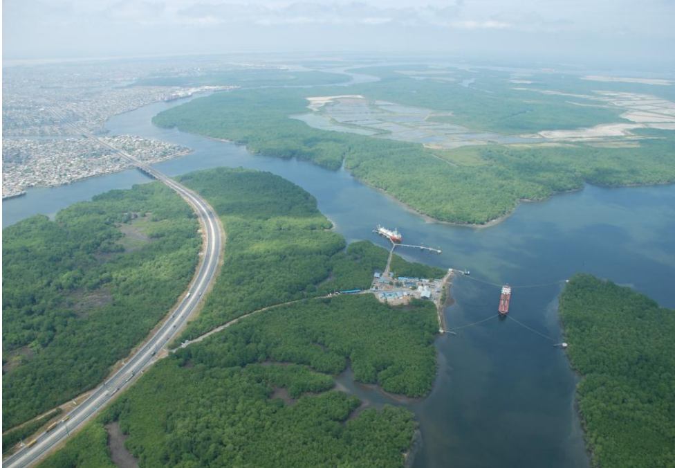
Foto 1- TERMINAL PETROLERO TRES BOCAS
