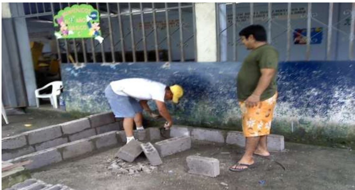
Figura 22. Maestros trabajando en la ejecución del proyecto en la escuela fiscal mixta N 4 “El TRIUNFO”.
