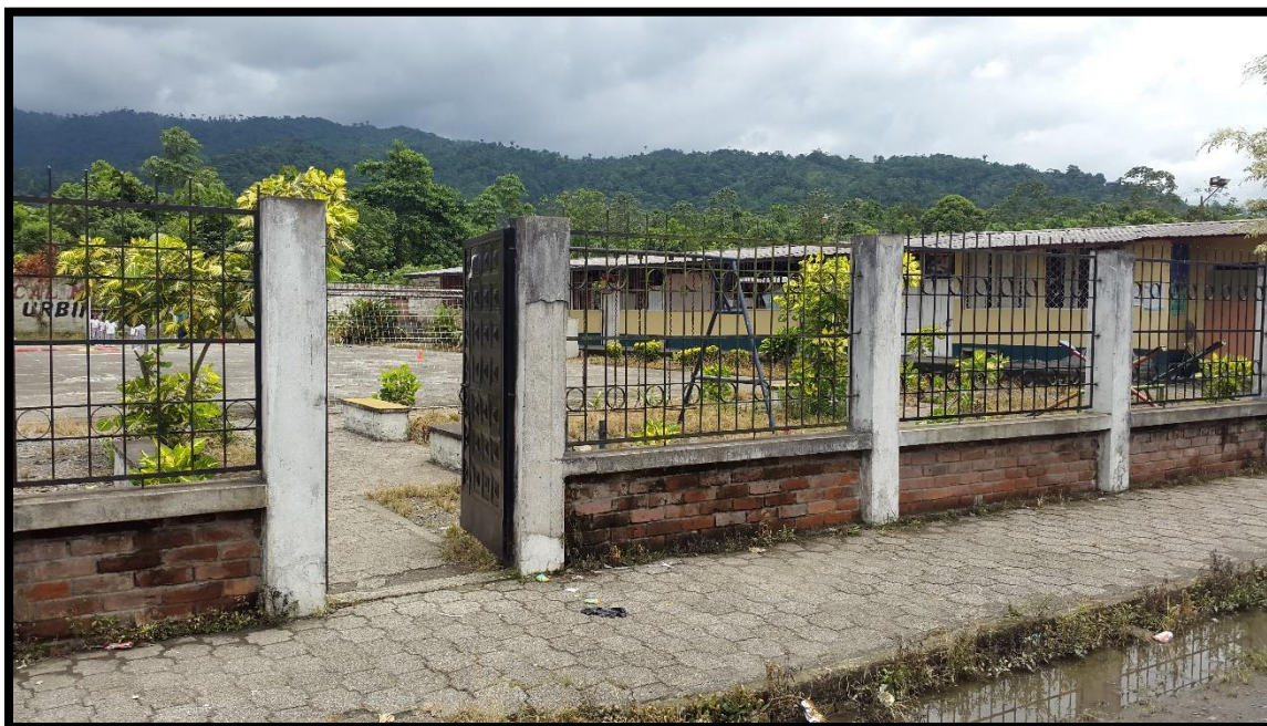
Figura 25 Foto exterior de la escuela José María Urbina
