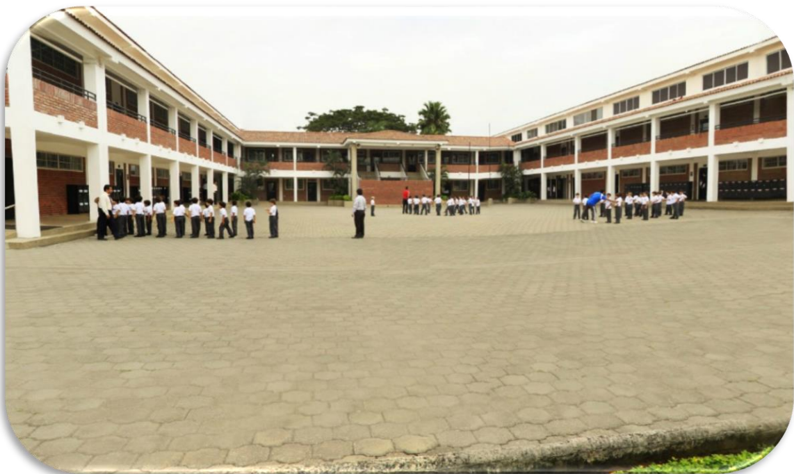
Figura 5.27: Instalaciones parte Interna de la Unidad Educativa Bilingüe Torreomar
