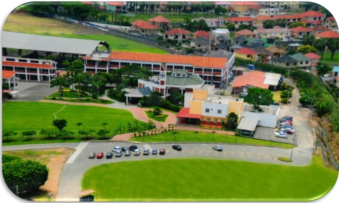
Figura 5.26: Instalaciones de la Unidad Educativa Bilingüe Torreomar
