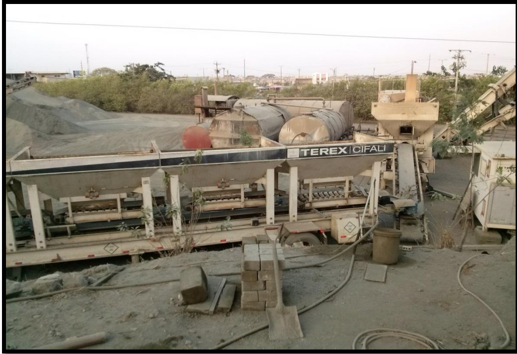
TOLVAS PARA EL DEPOSITO DE ARENA
