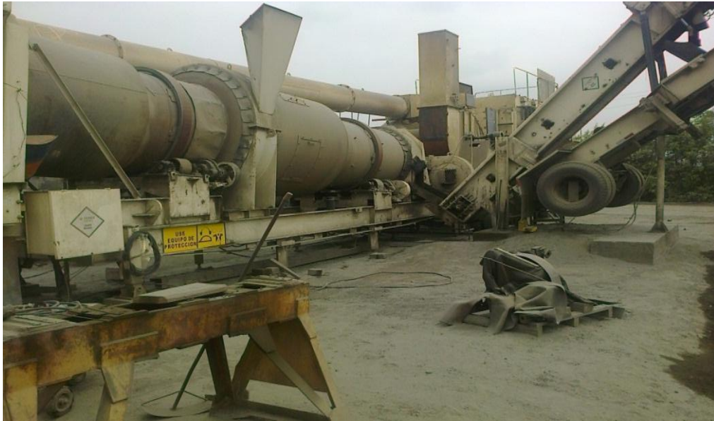
Figura 15. Área de mezcla asfáltica
