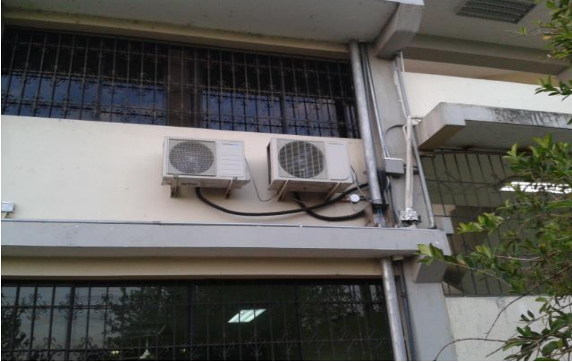
Descripción: Condensadores de sistema actual bloque K Fuente: Tomás Robelly y Miguel Robelly
