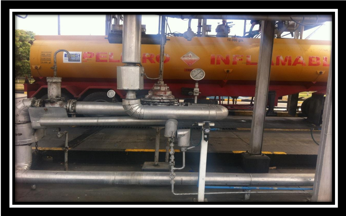
Anexo 9: Ubicación de la Unidad de Medida en la Isla de Carga.
