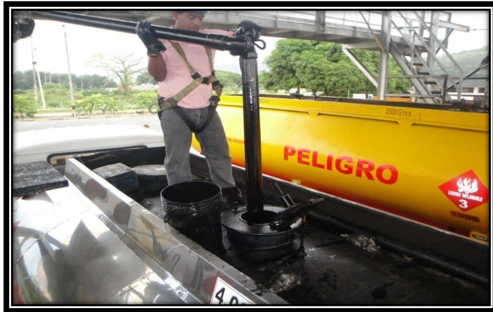
Figura 10: Brazo de descarga en una de las Islas en Terminal Fuel Oil.
