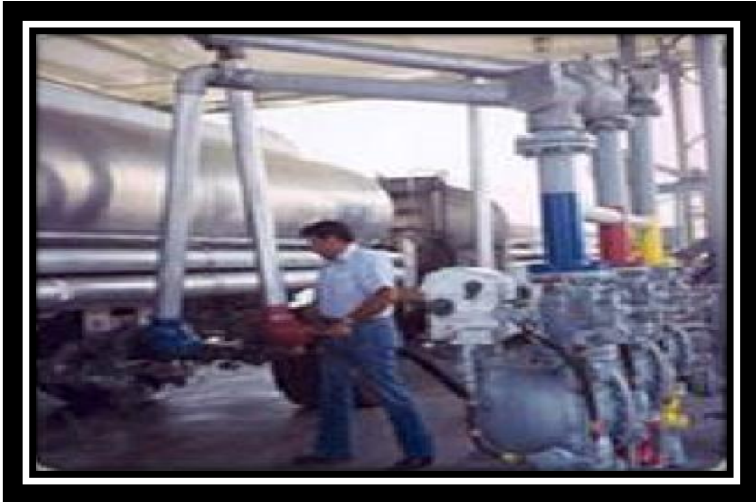
Figura 35: Llenado de auto tanque con sistema de carga ventral.
