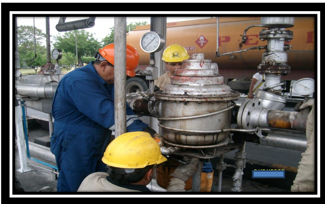
Figura 29: Personal de la empresa ECI realizando el desmontaje.
