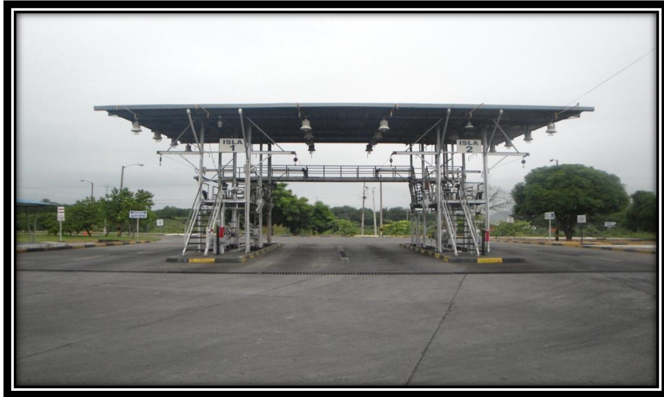
Figura 2: Isla de Carga con 4 brazos para el despacho en Terminal Fuel Oil.
