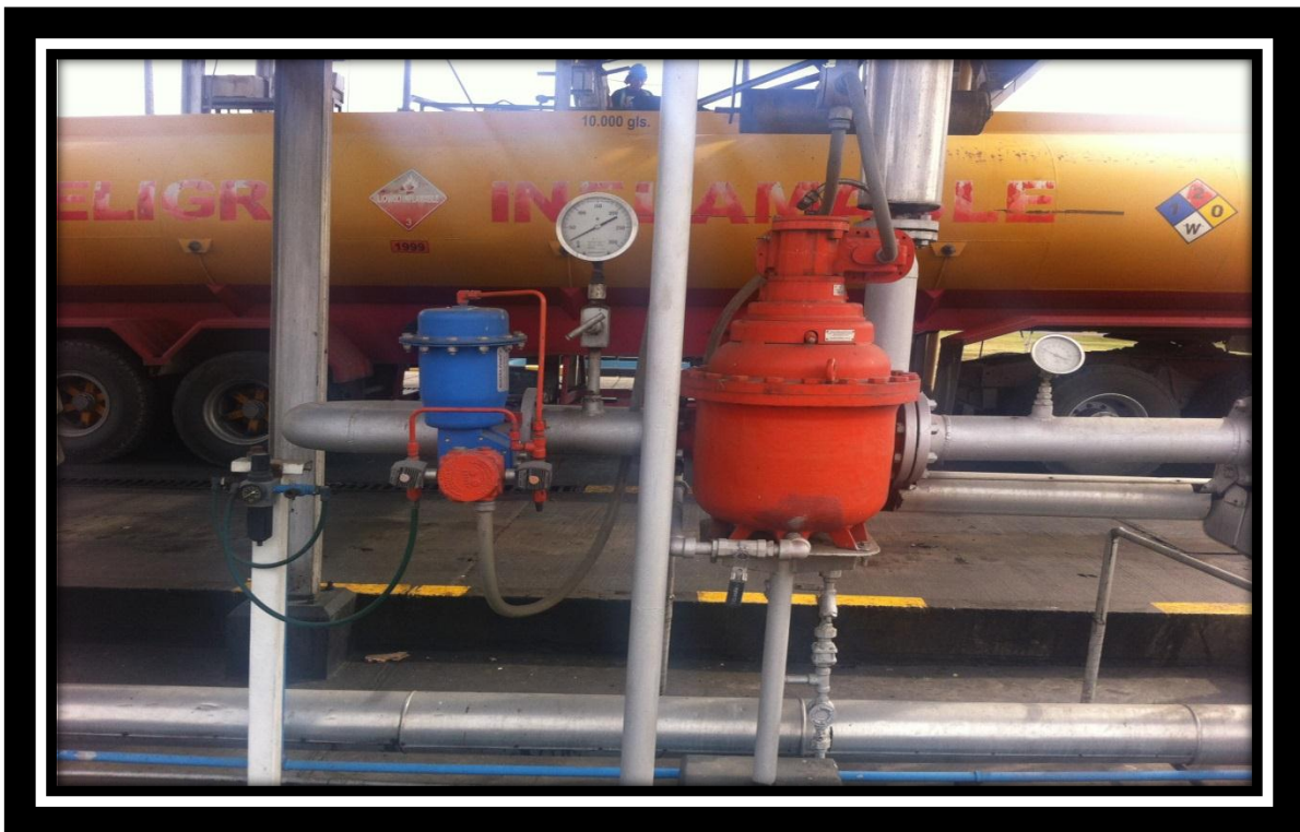
Anexo 15: Unidad de Desplazamiento y Válvula Automática.
