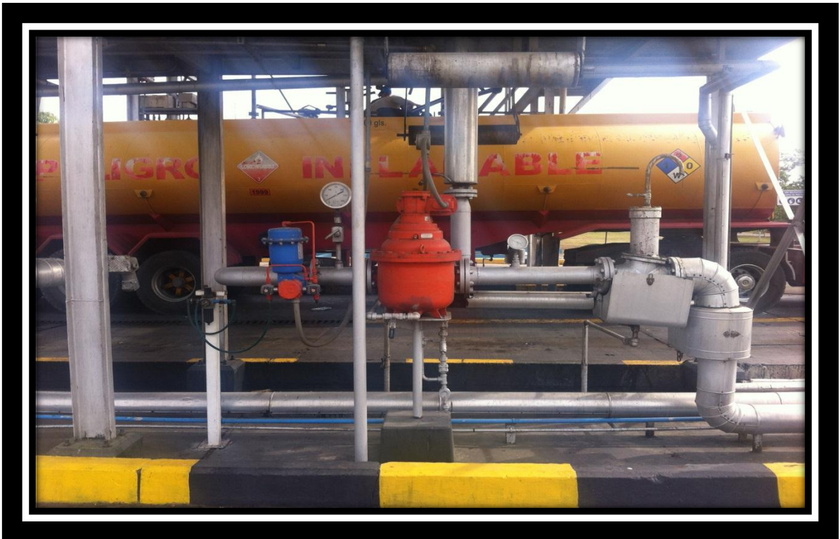
Anexo 14: Unidad de Desplazamiento y Válvula Automática ya reemplazadas.
