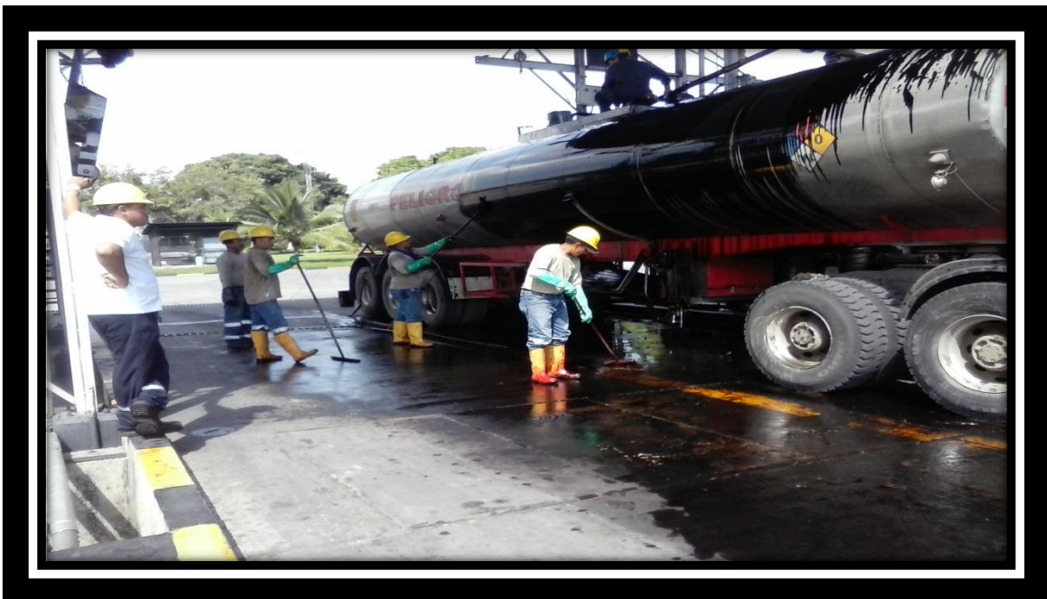
Anexo 8: Derrame de combustible por des calibración de la unidad de medida.
