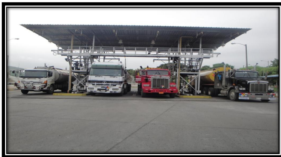
Figura 3: Isla de Carga en proceso de despacho a auto tanques en Terminal Fuel Oil.
