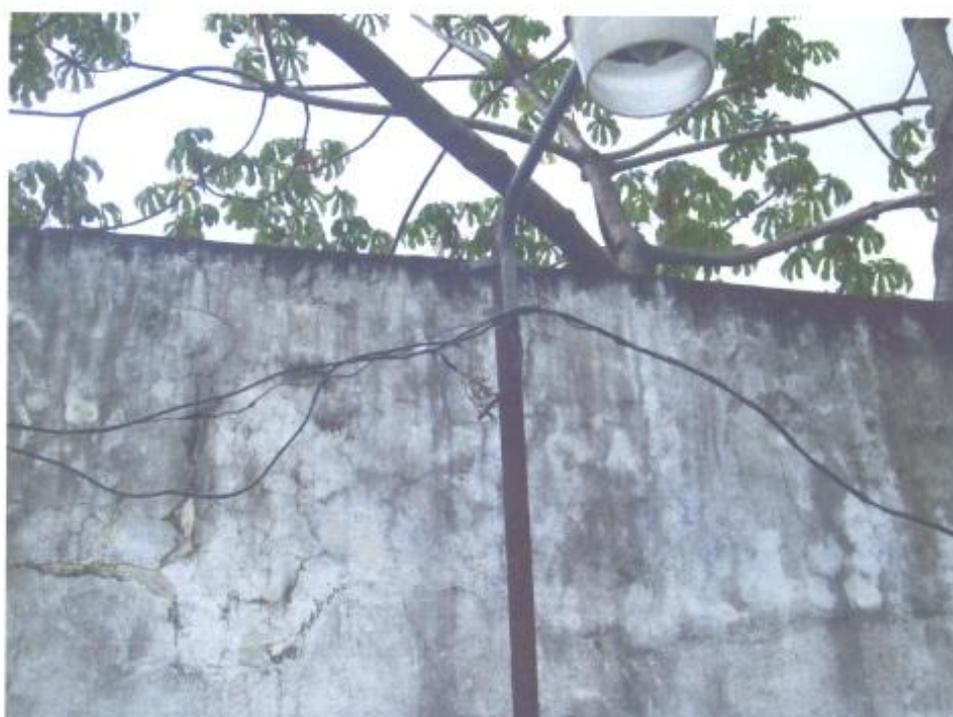
**Figura 4.8.** Cableado eléctrico sin protección y remendado
