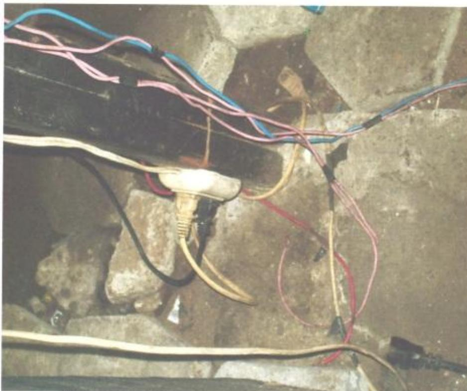
**Figura 4.7.** Conexiones eléctricas deficientes
