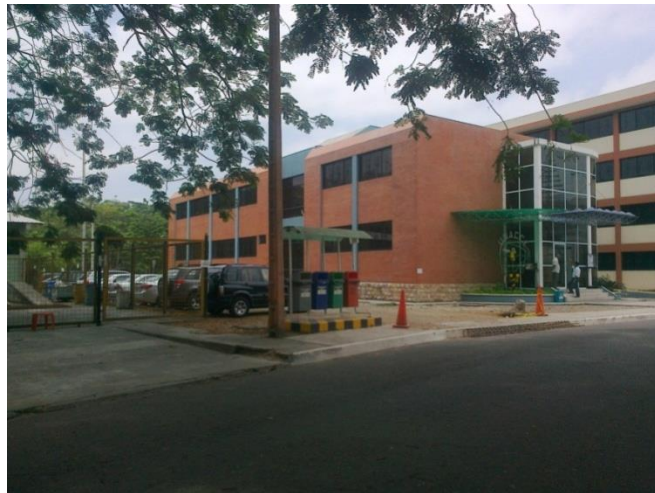
Falta de señalización de parqueadero
