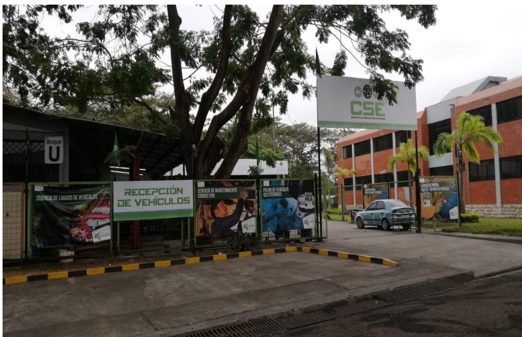
Ilustración 1: Vista exterior del CSE.
