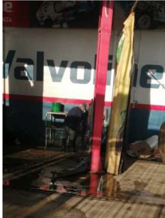
Anexo 7 Instalación de la lavadora de vehículos
