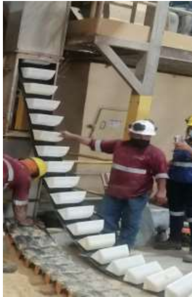
Foto 17. Limpieza e implementación de una nueva banda con sus cangilones.
