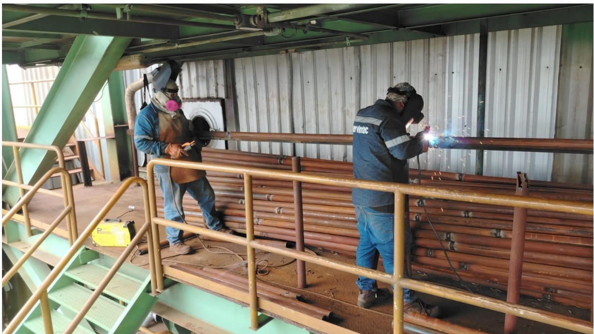
Figura 6. Trabajos en caliente - cambio de paredes laterales de caldera12.
